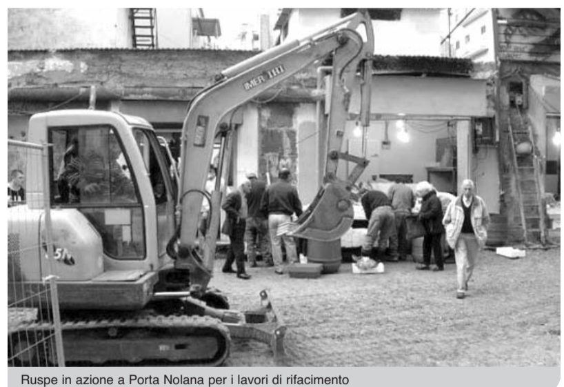
Ruspe in azione a Porta Nolana per i lavori di rifacimento
